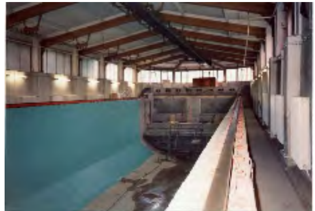
＜ベルリーン水槽の改修工事＞
