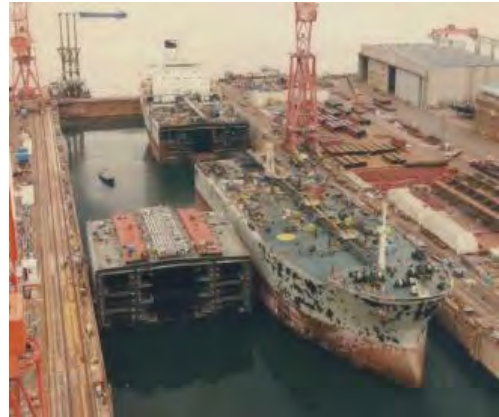
ジャンボライズ中 切断した船体中央に新造ブロックを挿入
