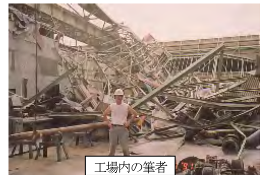
工場の屋根落下
