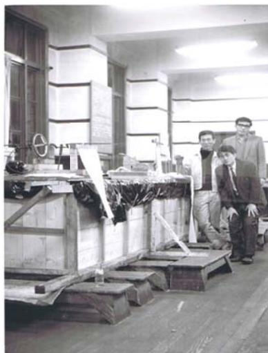
大学祭用に作製した木製水槽（長さ8m、幅0.8m、深さ0.65m）。手前が造波機・中央の記録装置も手製。弘明寺校舎・本館3階の製図室に設置。左より、山越、平山、湯浅。
