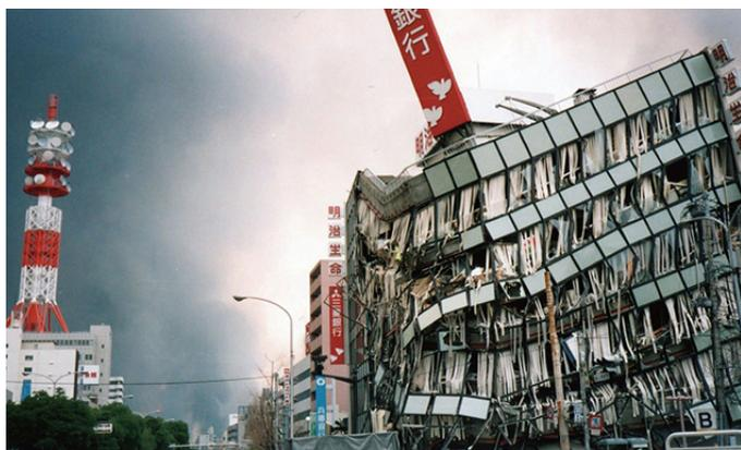
図6 崩壊中層銀行ビル(三宮)
