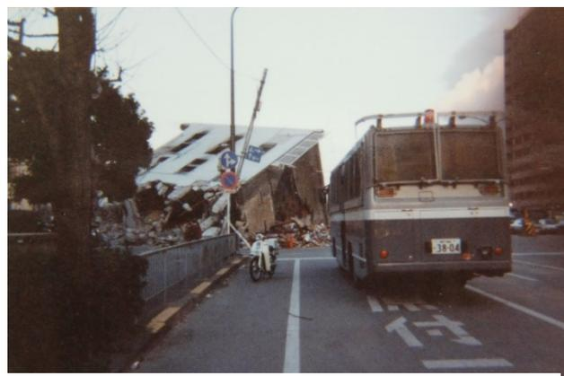
図7 横転倒壊中層ビル(三宮) 野澤撮影
