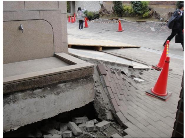
写真8 液状化で浮きあがった分、別の場所が沈下した（水洗場下に隙間発生）
