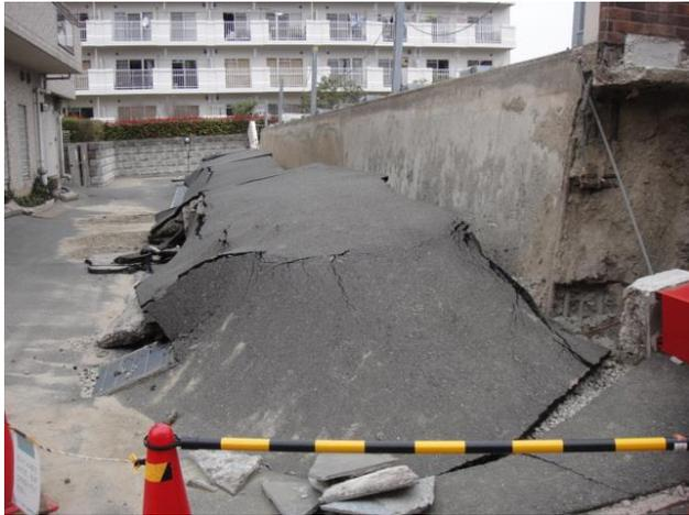
写真7 液状化で1 mくらい浮きあがった箱型半地下駐車場。上面が駐車面。自宅近くの金沢八景方面団地。2011年4月2日撮影。
