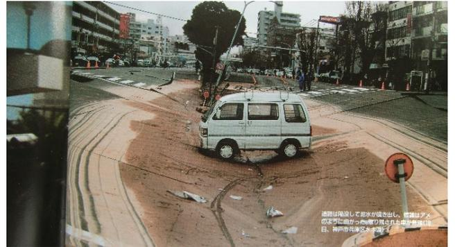
図 10 液状化/沈下道路（三宮） サンデー毎日
