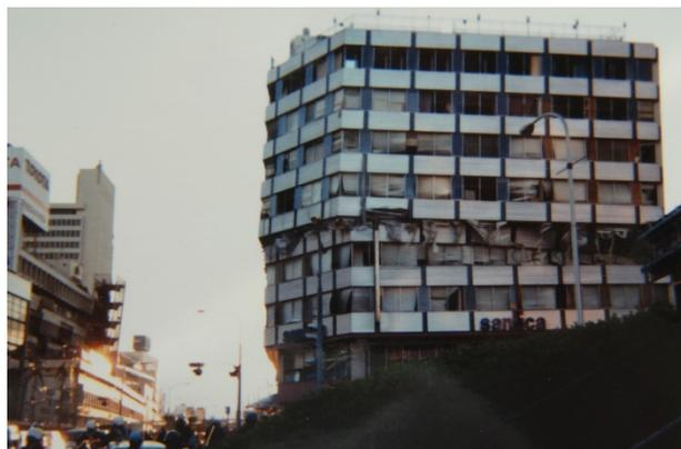
図5 座屈崩壊高層ビル(三宮) 野澤撮影
